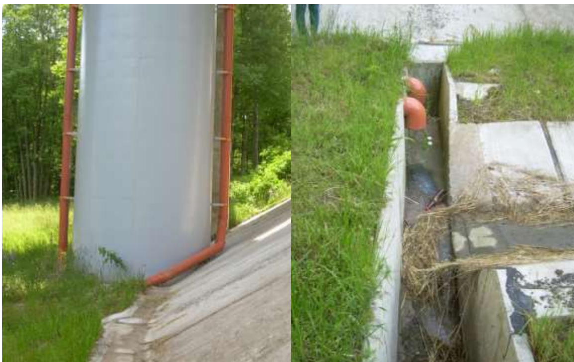
Рис. 5. Слив в бетонный лоток
