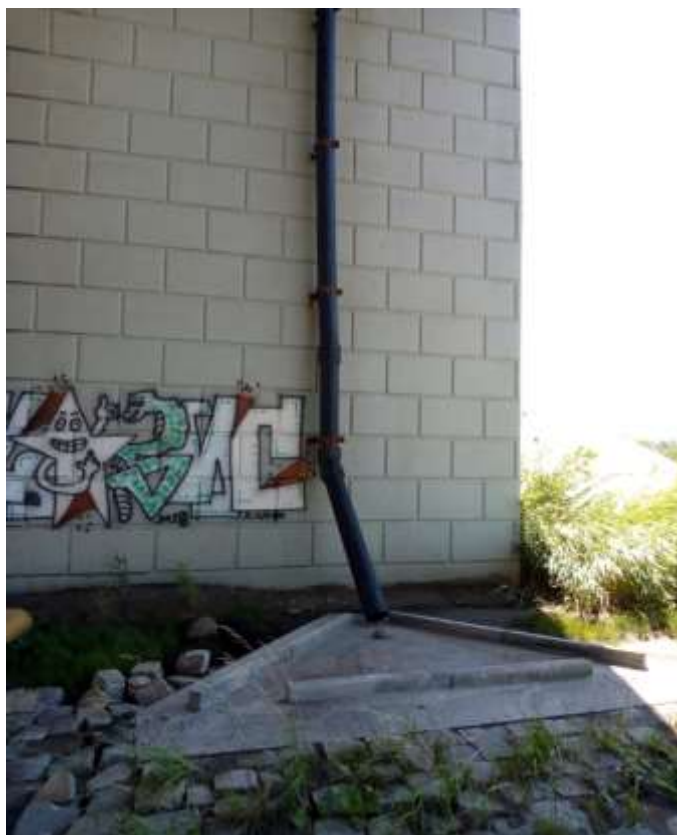
Рис. 9. Водовыпуск с гасителем энергии
