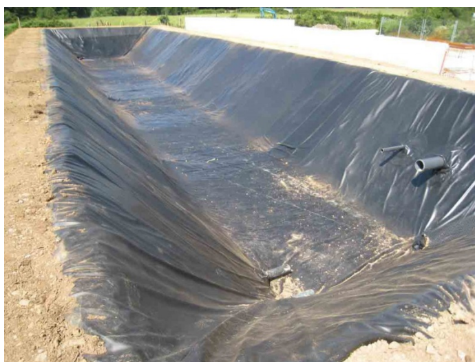
Рис. 2. Гидроизоляция шламового амбара
