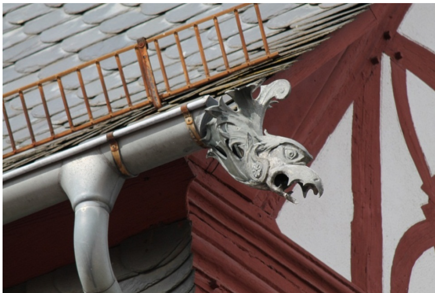
Рис. 13. Архитектурный элемент водостока
