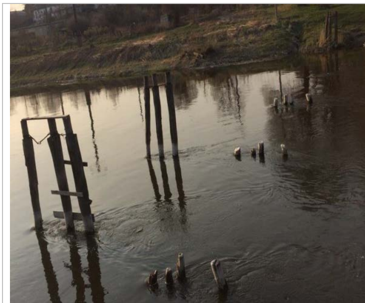
Рис. 3. Опоры моста, г. Правдинск (апрель 2019 г.)
