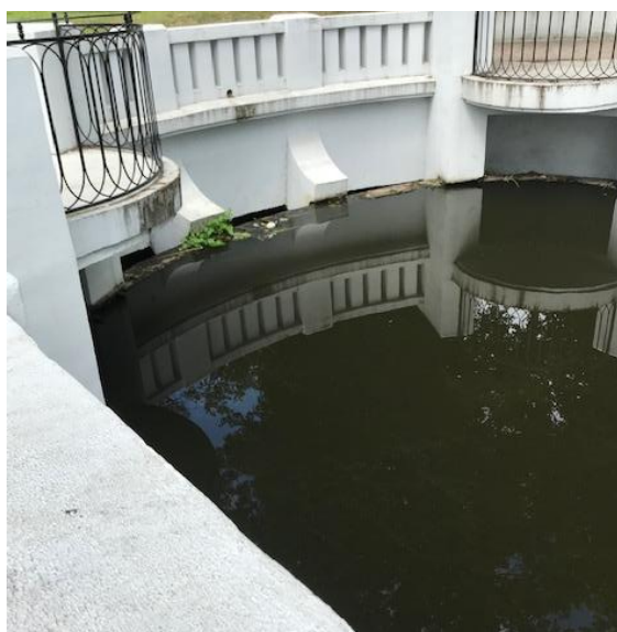
Рис. 3. Центральная часть водосливной грани
