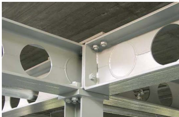
Рис.5. Вварные вставки в районе опорных сечений балок с круглыми вырезами
