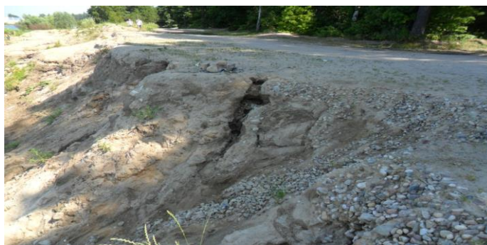
Рис. 4. Формирование водобойного колодца в отвершке оврага
