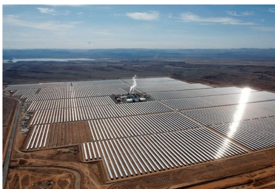
Рис. 4. Панорама солнечной коллекторной электростанции в Марокко (580 МВт)
