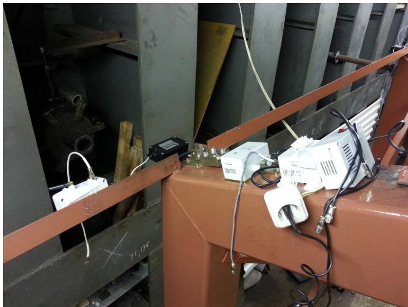
Рис. 2. Датчики измерения деформаций, установленные на элементах рамы
