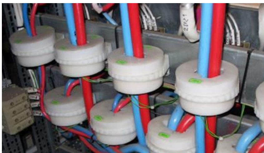
Рис. 1. Внешний вид датчиков тока утечки системы СКИФ
