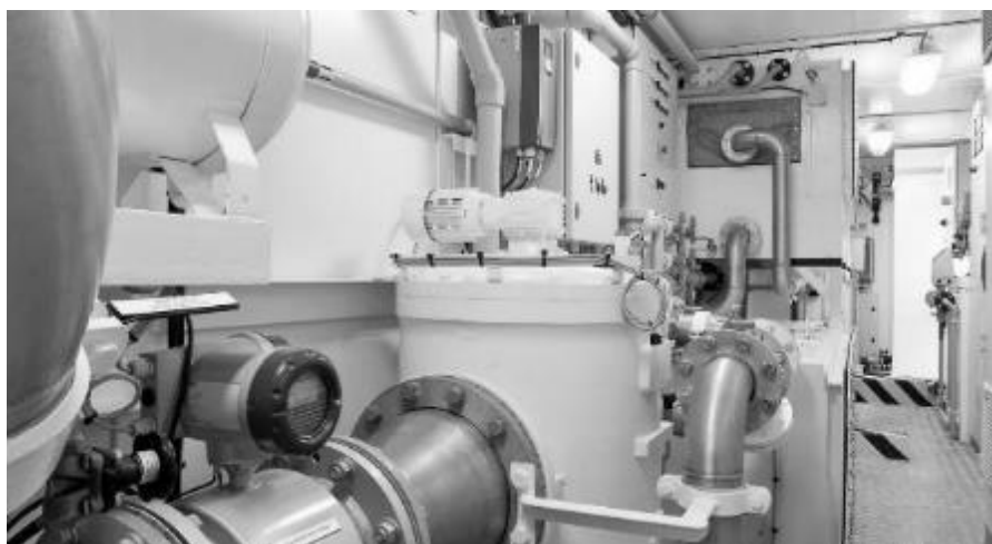
Рисунок 2. Система очистки судовых балластных вод в мобильной конфигурации InvaSave [5].
