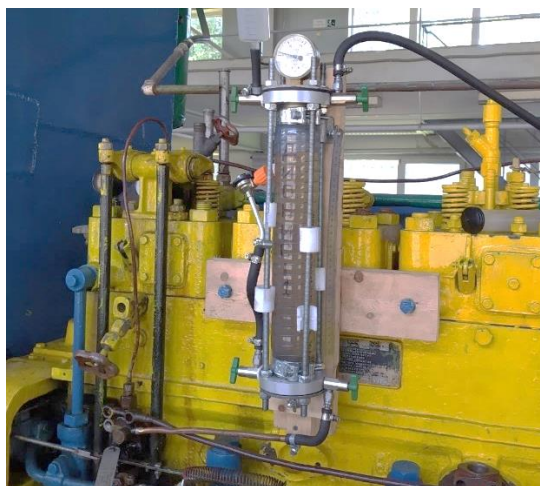
Рис. 2. Монтажа смесительного устройства на двигателе NVD-24
