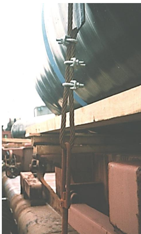
Рис. 6. Не правильно установленные тросовые зажимы при изготовлении огонов
