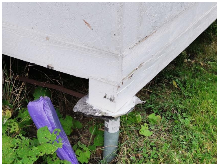
Рис. 4. Снятие материала ориентированно-стружечных плит.
