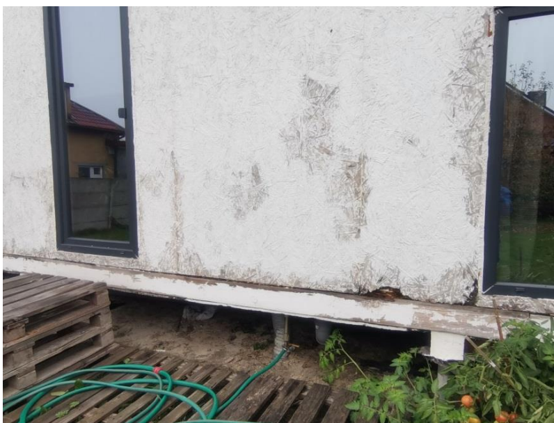
Рис. 3. Гниение ориентированно-стружечных плит..
