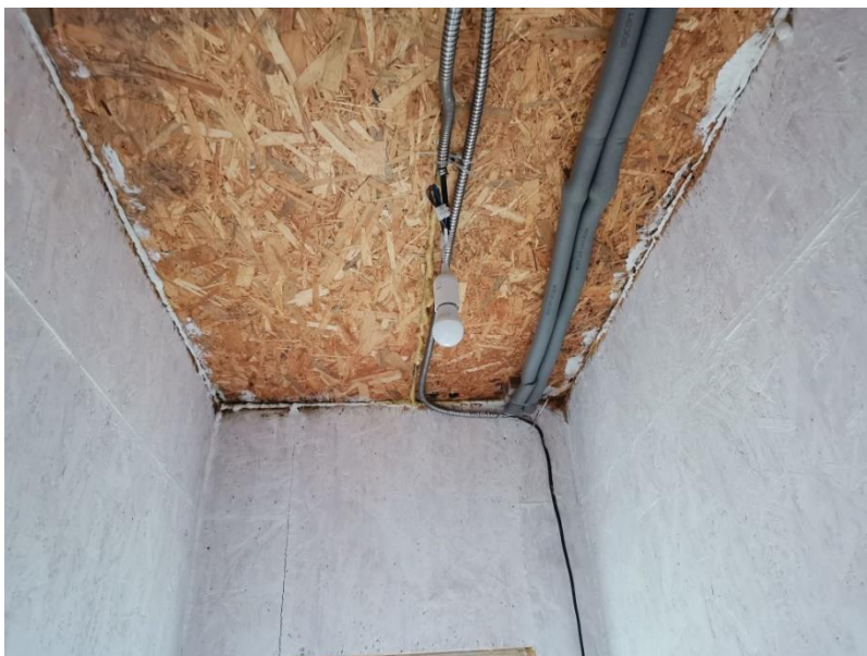
Рис. 2. Гниение ориентированно-стружечных плит.
