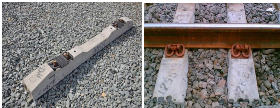
Рис. 1. Железобетонные шпалы со скреплением анкерного типа APC-4
