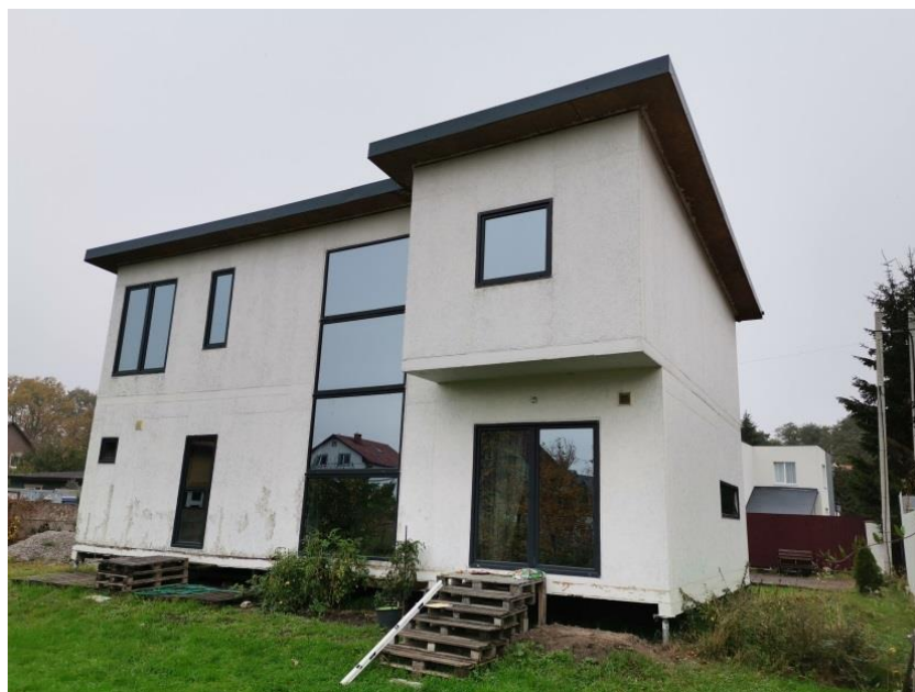
Рис. 1. Общий вид здания.
