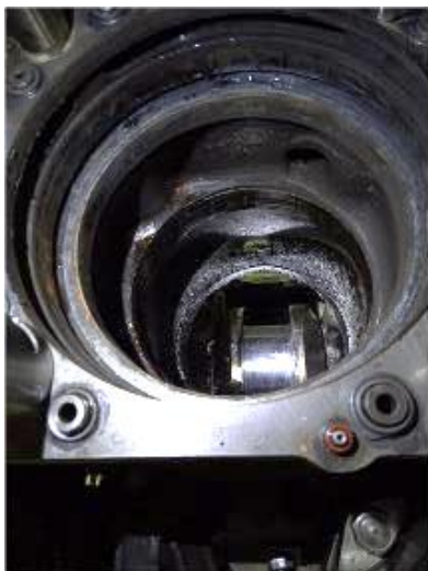
Фото 19. Посадочное гнездо втулки цилиндра. На нижнем центровочном поясе имеется сквозное отверстие от точечного удара и трещина.
