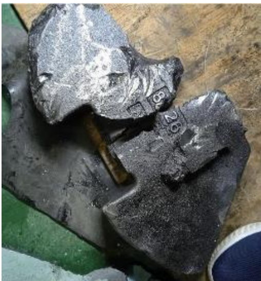
Фото 16. Разрушение противовеса по оси шпильки от боковых ударов
