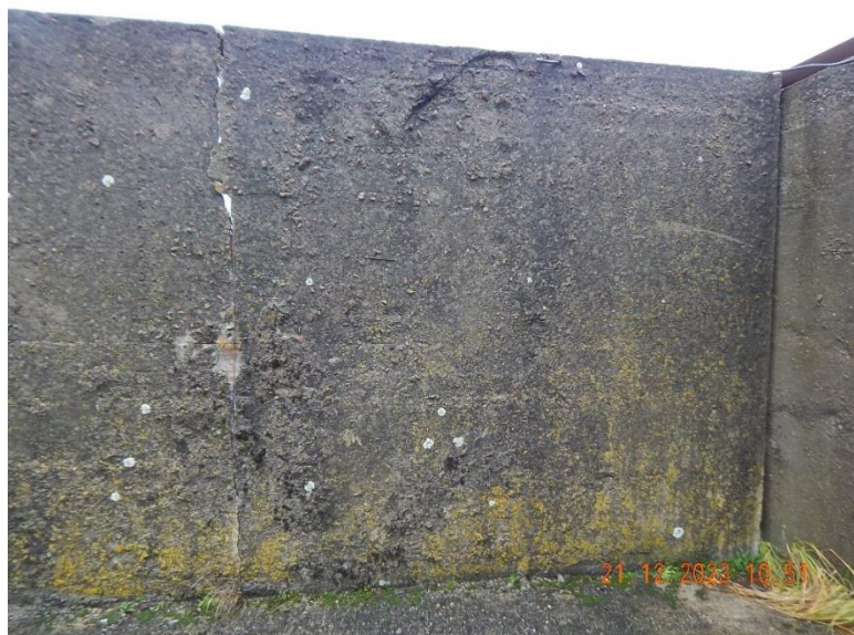
Рис. 1. Ж/б панели забора, примененные в качестве внутренних перегородок.
